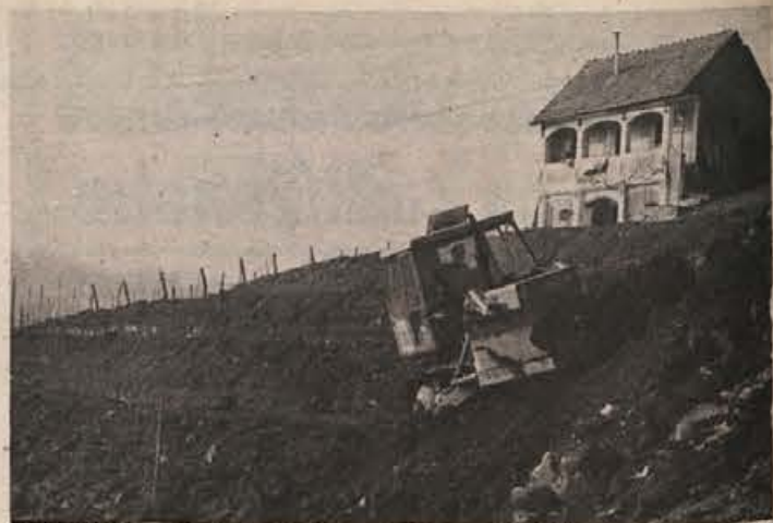
VIDOVIČI - Pogled na vinograd, ki temeljito spreminja obliko. Še lani so Belokranjci tod vinograde zaradi hude položnosti težko obdelovali. Poslej bo drugače: vinogradniška strojna skupnost bo poskrbela, da bo življenje vinogradnikov v teh predelih precej lažje. Na sliki: buldozer spreminja klasičen vinograd v terase. (Foto: Janez Pezelj)
