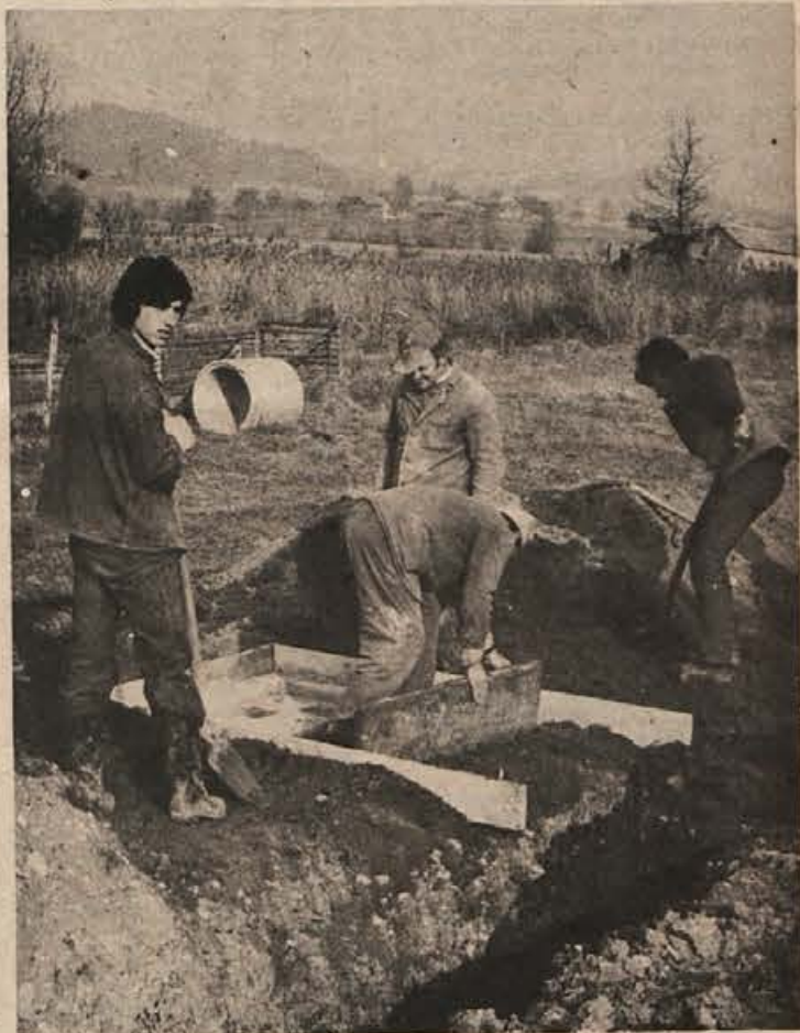
Kaže, da bo mirenška čiščilna naprava le pričela delati. Nerešeno je še vprašanje nekaterih dovodov kanalizacije. Na sliki: delavci gradbene skupine Dane pri zaključnih delih ob zadnjem jašku.
