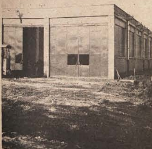
Pionirjev TOZD Mehansko-kovinski obrat bo poslej opravljal tehnične preglede vseh vrst motornih vozil v novih prostorih v Mačkovcu pri Novem mestu. Objekt bo sodobno opremljen in bo olajšal preglede, ki so jih doslej opravljali v neprimernih prostorih. (Foto: Vesel)
