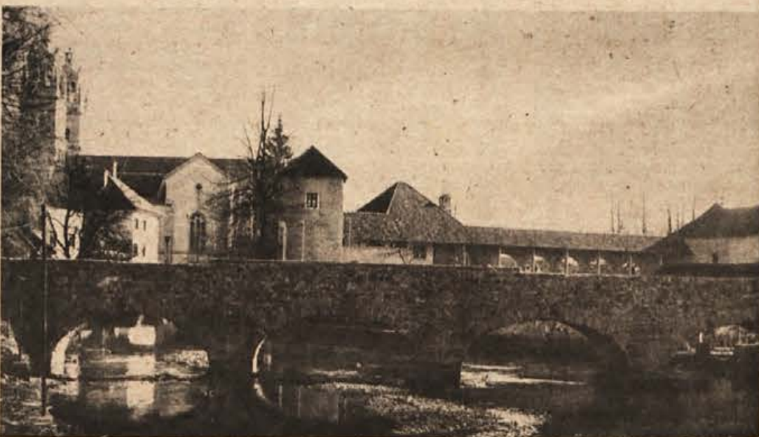
Potok oziroma rečico Bistrico, ki teče skozi Ribnico, je treba očistiti oziroma poglobiti kar za 60 cm ali več, razen tega pa se znižati zapornice pri cerkvi za 80 cm. Zaradi zatrpne struge (glej sliko) se namreč gladina vode občutno dvigne, Bistrica prestopi bregove in v Ribnici je poplava. (Foto: J. Primc)
