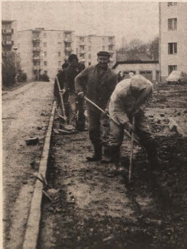
V središču Metlike so delavci TGP prejšnji teden urejali okolico blokov. Na sliki: delavci popravljajo pločnike (Foto: J. Pezelj)
