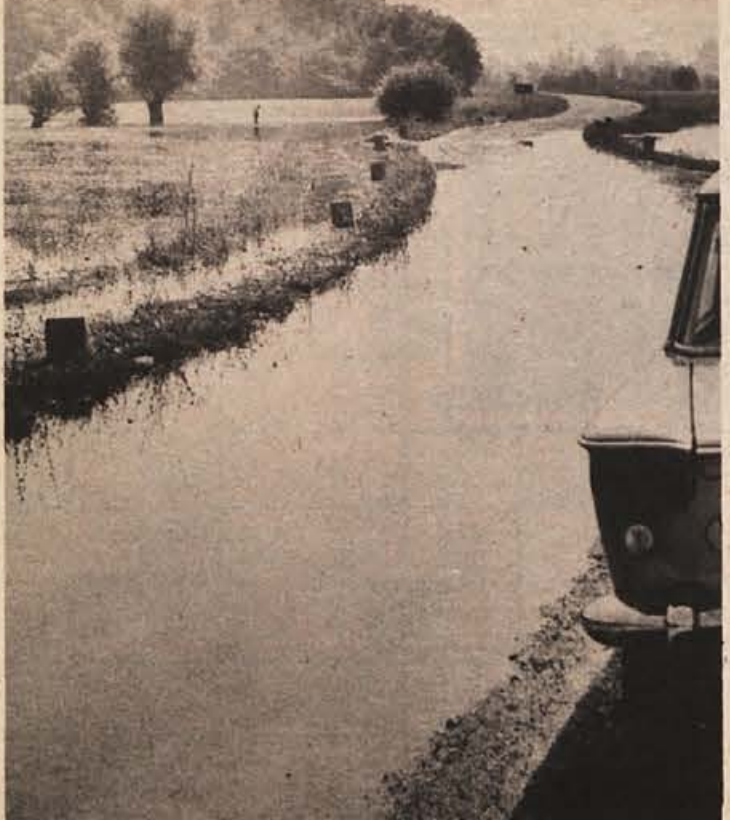
Presneto deževje! Kakšen dan je malo več, kakšen dan pa malo manj vode na cesti med Kostanjevico in Zameškim, v glavnem pa je vsa jesen cesta nepravozna. Podobnih cestnih odsekov imamo še več, kajti vse vode silijo čez breg. (Foto: R. Bačer)
