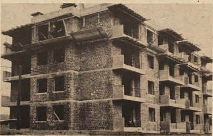
Gradbena dela v novem 24-stanovanjskem bloku ob gozdarskem domu v Ribnici se v glavnem bližajo koncu. Pričakujejo, da bo vseljiv za občinski praznik, se pravi marca prihodnje leto. Še letos bodo poleg tega začeli graditi še en skoraj enak blok, katerega gradnjo bodo sofinancirale delovne organizacije in solidarnostni stanovanjski sklad. (Foto: J. Primc)
