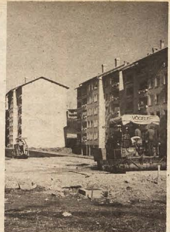
Urejanje okolice na Ragovski cesti pri novih blokih se približuje koncu. Prejšnji teden so delavci Vodne skupnosti asfaltirali cesto in parkirne prostore. Dela bi bila narejena že prej, če jim ne bi nagajalo slabo vreme.
