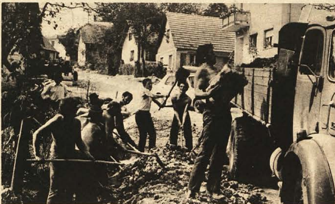
Te dni vaščanom Stopič ni bil noben kamen in nobena lopata pretežka, saj bodo končno pričakali asfaltiranje ceste, za katero so že pred leti pričeli zbirati denar. Pred asfaltiranjem pa so uredili še kanalizacijo in druge priključke, da ne bo treba kasneje asfalta prekopavati. (Foto: S. Mikulan)
