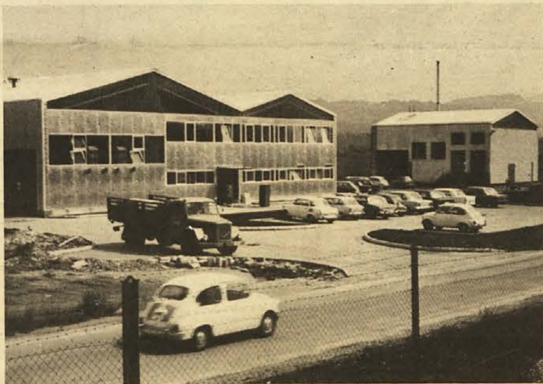
V soboto bodo v Trebnjem odprli Novolesovo tovarno akrilnih plošč, ki že poskusno obratuje. Zgrajena je za zmogljivost 1.000 ton plošč, bodočnost tovarne pa je v predelavi plošč v akrilno steklo. V novi tovarni je dobilo kruh 70 delavcev.
