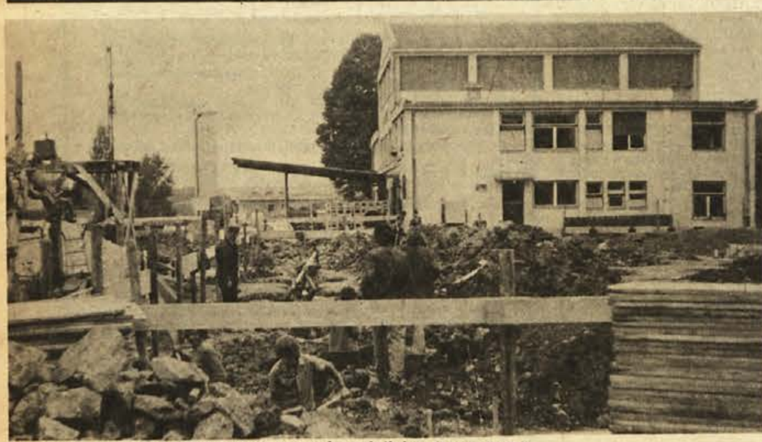
Gradbišče pri vinski kleti, kjer bo avtomatska polnilnica. (Foto: B. P.)
