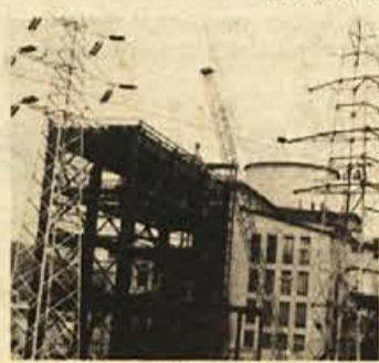
Gradbišče elektrarne v Brestanici
