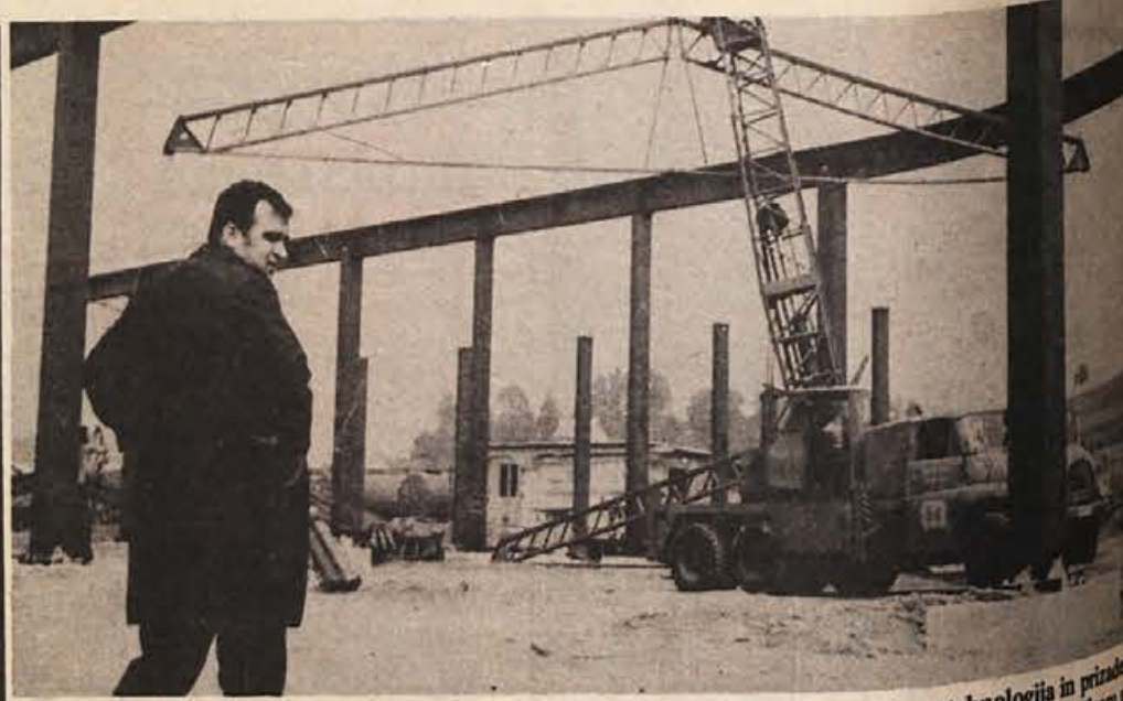
Delavci „Trima“ skušajo pri gradnji tovarne narediti kar največ sami, njihova tehnologija in pripravnost pa naj bi tudi na Dolenjskem, kjer imajo še najmanj naročil, pokazala to, kar je znano že široko po državi. Na sliki: nameščanje strešnih elementov.
