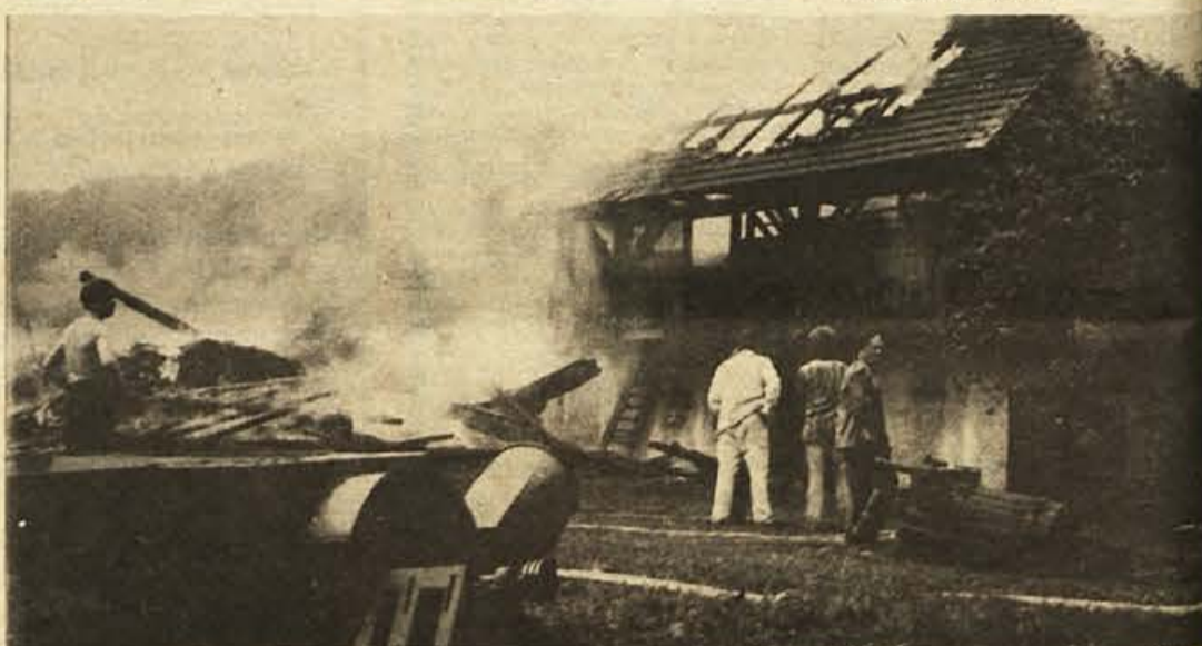
Gasilci so s požrtvovalnostjo brzdali veliko baklo požara. Na sliki levo so ostanki kozolca in krmne desno pa gospodarskega poslopja.
