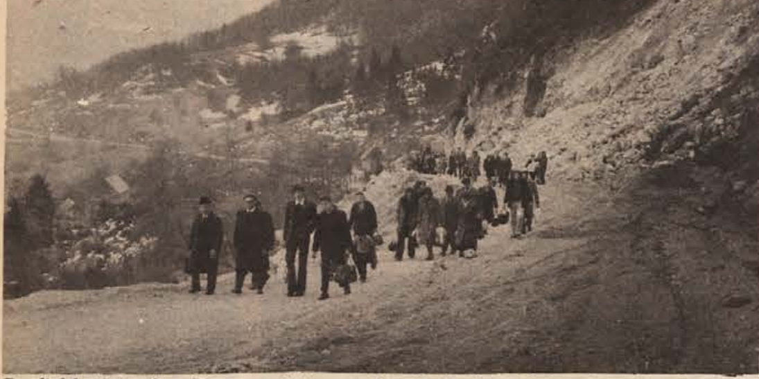
Zaradi del v Colnarskem klancu na odseku ceste Kočevje-Brod na Kolpi morajo potniki prestopati z avtobusa na avtobus in del poti tudi prepešati. (Foto: Z. Vardijan)
