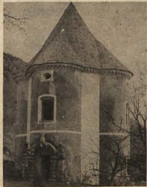
Hudičev turn, nekdanji grajski vrtni paviljon, je zdaj zaščiteno in obnovljeno
