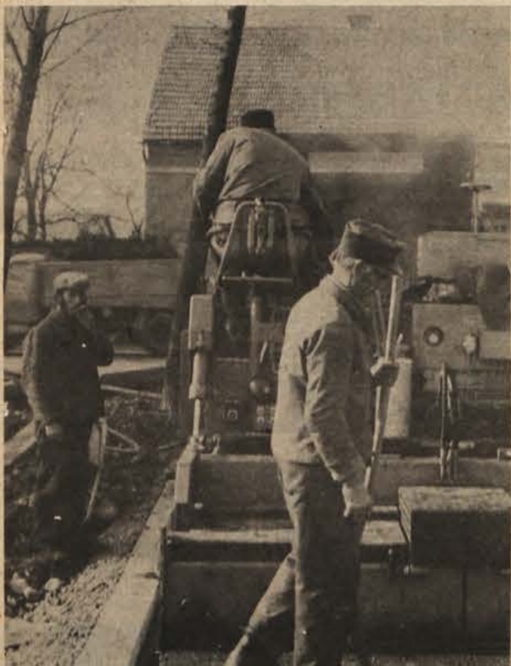
Asfaltiranje brežiških ulic z novim finišerjem, ki ga je letos kupil cestni sklad za hitrejšo modernizacijo občinskih cest. (Foto: Jozica Teppey)
