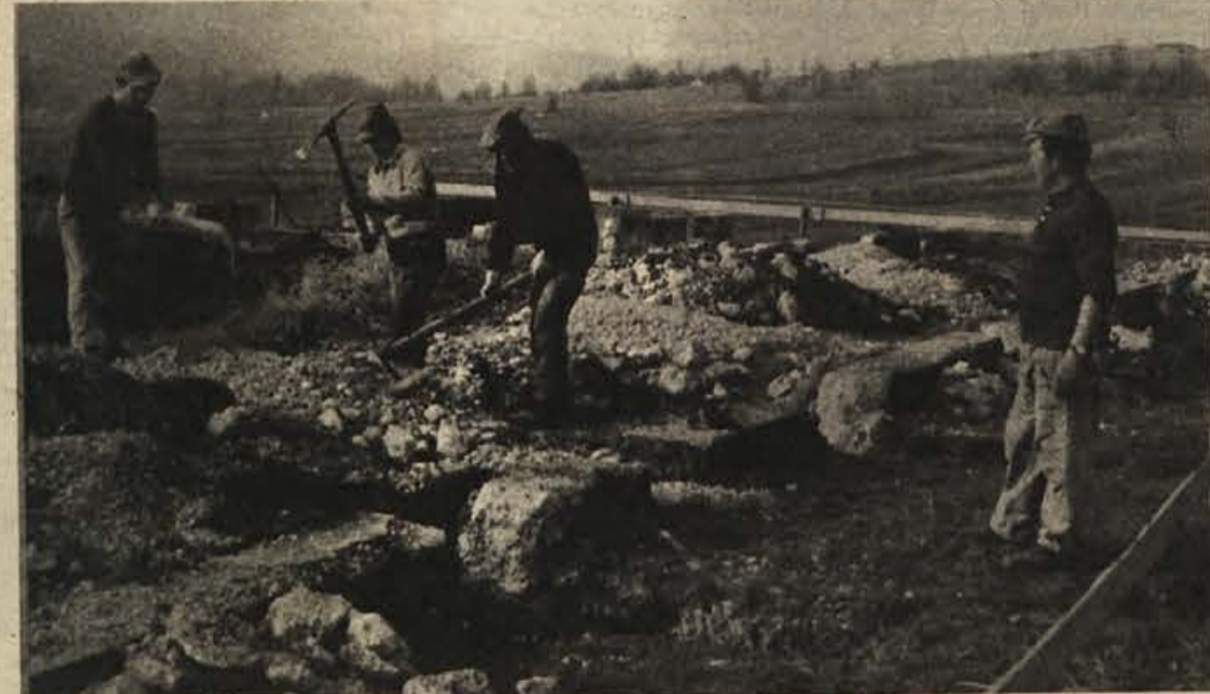
26. oktobra letos so začeli v Dolenji vasi pripravljati temelje za telovadnico oziroma novi družbeni center. Že letos bo postavljeno montažno ogrodje, junija prihodnje leto - ko bo minilo natanko 20 let, odkar so bili narejeni prvi načrti za ta center - pa naj bi stavbo svečano odprli. (Foto: J. Primc)
