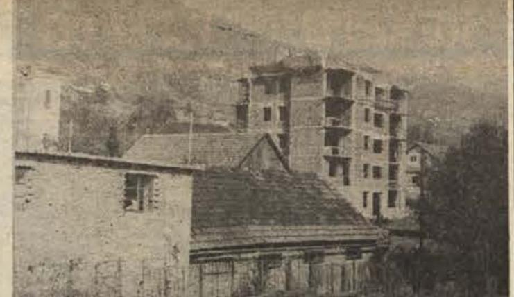
Stanovanjski blok, ki ga gradijo v Semiču, je vsak dan bolj podoben stanovanjski stavbi. Kmalu se bodo vanj vselili srečni dobitniki stanovanj. (Foto: B. Podobnik)
