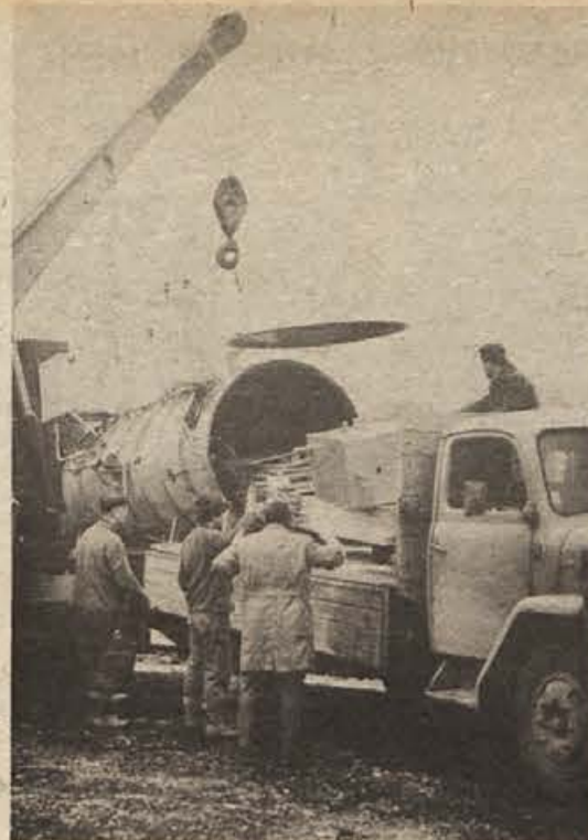
Minuli petek je dobila sevniška KOPITARNA naj sodobnejšo opremo za lesno sušilnico. To je doslej tretja tovrstna oprema v državi. Nova oprema spada v sklop prizadevanj za posodobljanje tovarne. Na sliki: raztovarjanje kotlov z vagonov. (Foto: Železnik)
