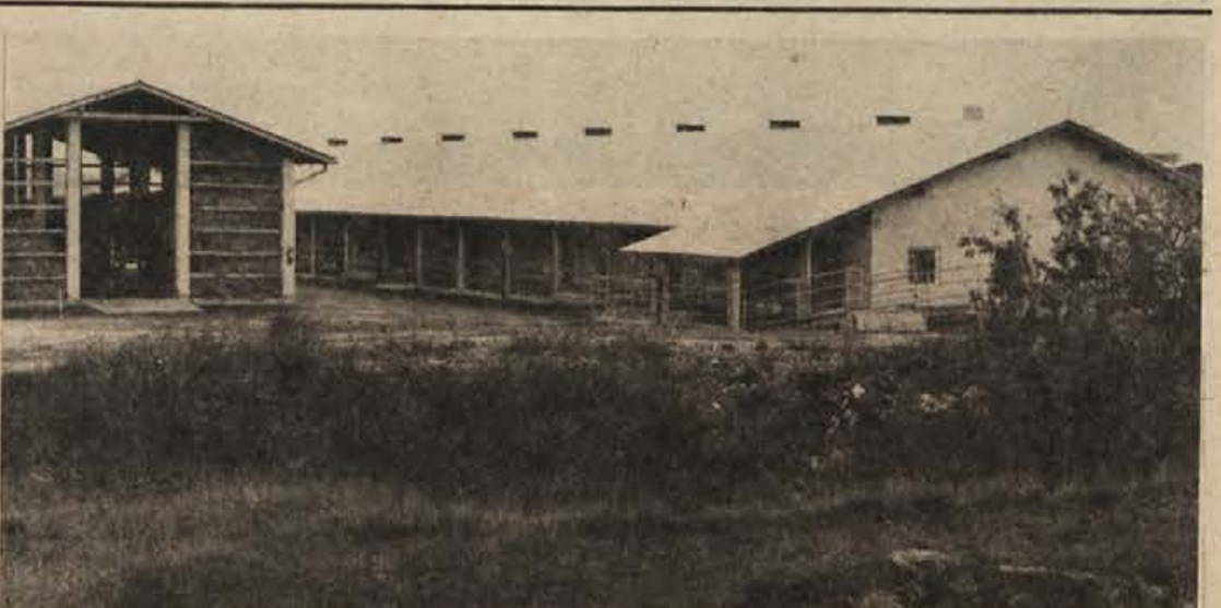
Pogled na moderno urejene hleve, ki jih je v Dobovi zgradila GRUDA. (Foto: M. Vesel)
