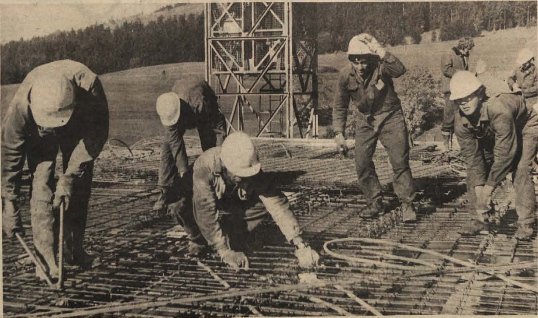
Outinord opaž je postavljen in železokrivci na vso moč hite polagati armaturno mrežo na zgornji etaži, ki je že dobrih 35 m nad tlemi. (Foto: M. Jakopec)
