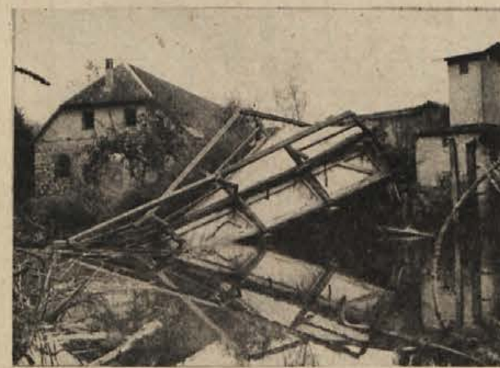
Takle je podrti most na Dvoru, zaradi katerega je promet proti Kočevju čez Suho krajino in Smuko onemogočen. Most se je podrli, ko je pretekli teden čezenj zapeljal tovornjak. Na srečo vsaj žrtv ni bilo. (Foto: Sandi Mikulan)
