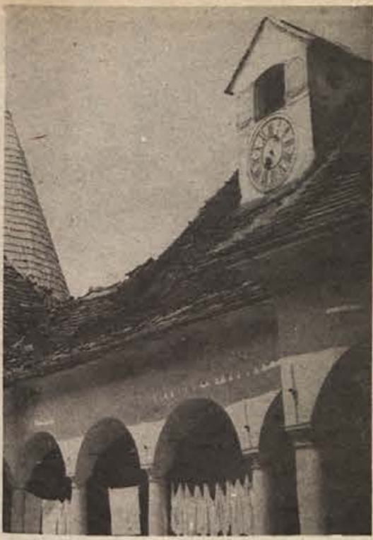
Na sliki bizelski grad, na katerem so pod vodstvom Posavskega muzeja spomladi začeli obnovljati streho. Dva stolpca so prekrili s škodlami in jima zamenjali trholo ostriše. Škoda, da je grad sicer tako zapuščen in zanemarjen. (Foto: J. Teppy)
