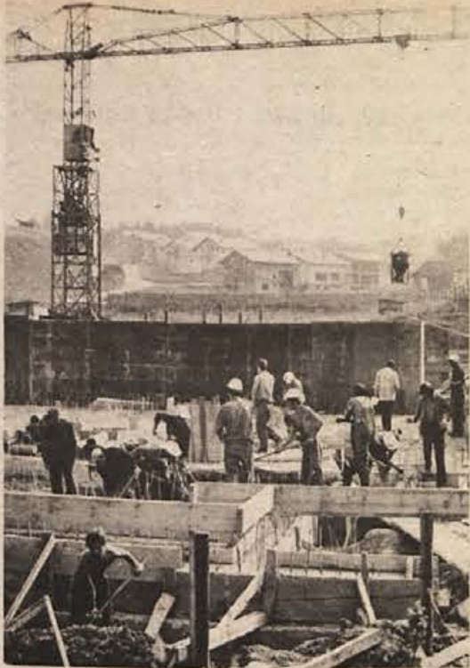
Na Brudarjevih njivah so „Pionirjevi“ delavci pričeli graditi dve stolpnici, ki bosta omilili stanovanjsko stisko. Ob sedanjih cenah pa je vprašanje, ali bodo do stanovanj prišli tisti, ki so jih najbolj potrebni.
