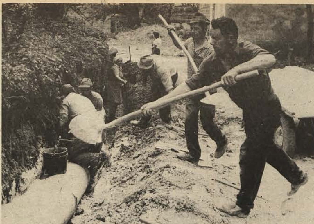
Kanalizacija je drugo skupno delo vaščanov Dolnjih dol – pred leti so takole napeljevali cevi za vodovod. (Foto: I. Zoran)
