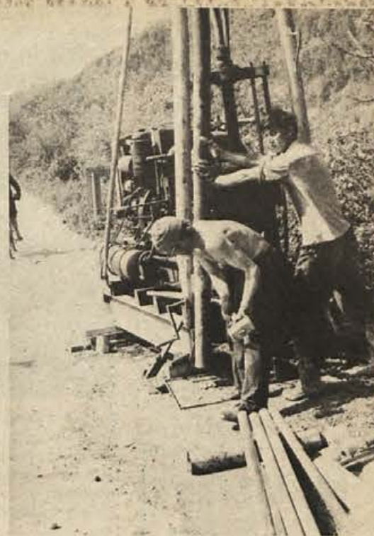
Za novi most čez Savo v Sevnici gre že zares. Vrtalci republiškega geološkega zavoda so minuli teden že končali sondiranje tal na bregovih, v tem tednu vrtajo v strugi. Zaenkrat vse kaže, da so tla za most ugodna. Most naj bi bil nared prihodnje leto tak čas. (Foto: Zeleznik)
