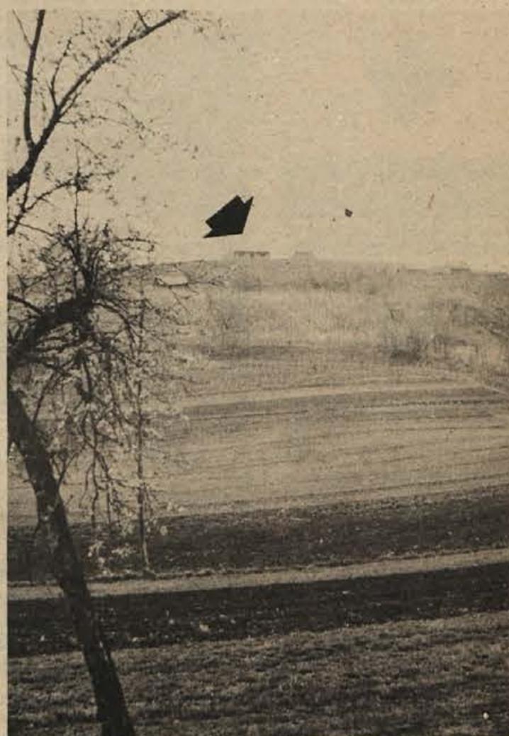
Sredi vinogradov je na vrhu pobočja obstala gradnja vikenda. (označen s puščico). Do prve plošče ga je zgradila Jožica, potem je njene načrte končal strel.
