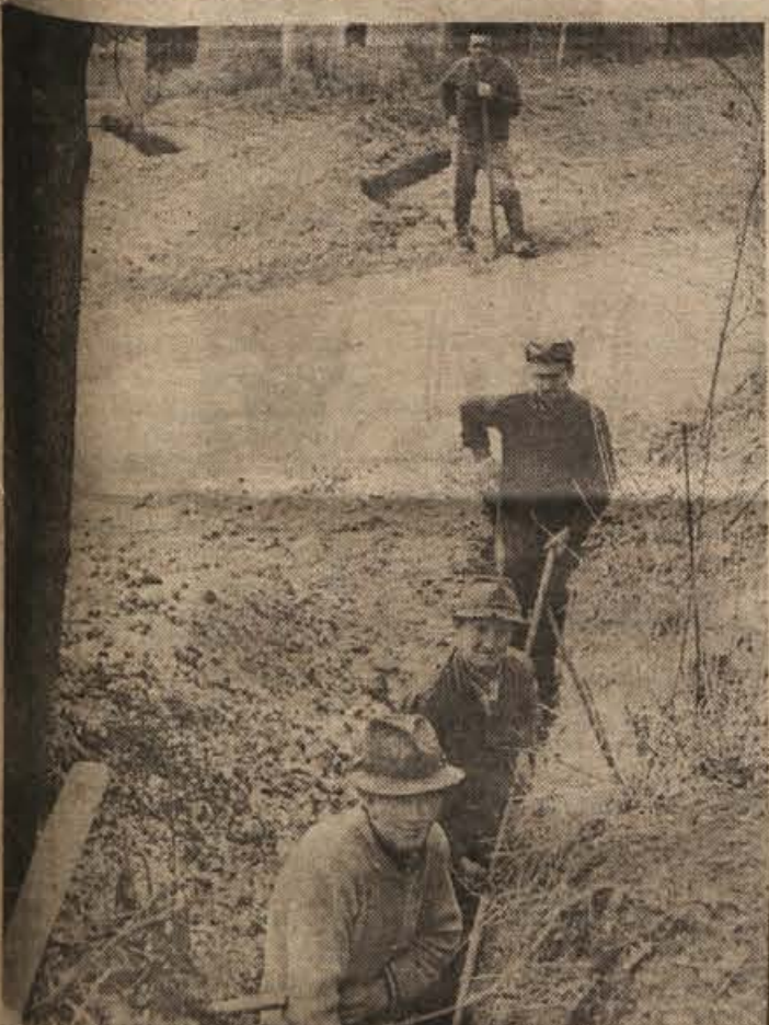
VELIKI CIRNIK, vas na hribu, nikjer druge vode razen kapnice. Resničnost, ki bo držala le še malo dni. Za vodovod iz doline je dalo 17 gospodinjev po 3.500 dinarjev. Na sliki: kopanje zadnjih metrov jarka proti zbiralniku 90 metrov nad izvirov. (Foto: A. Železnik)
