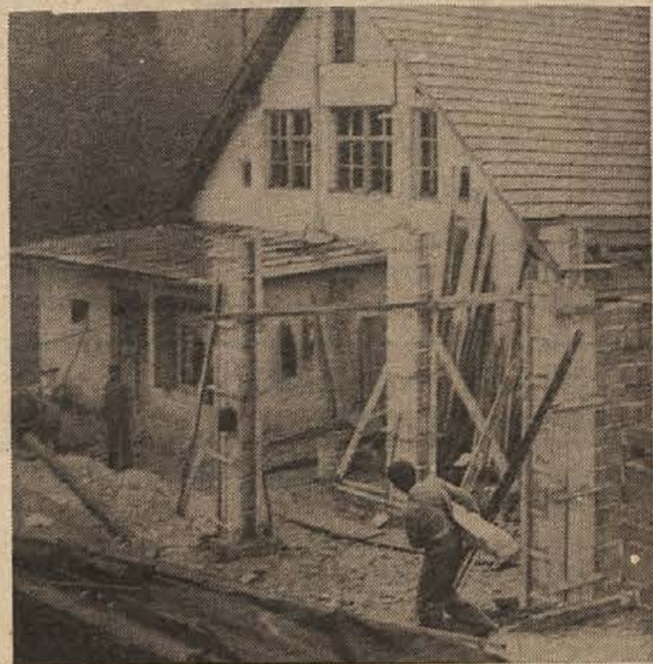
Tudi mali se razvijajo: na sliki gradnja prizidka pri šentlovenskem HRASTU. S stiskanjem pasu so zbrali 650 tisočakov, s tem pa bodo pridobili kar 240 površinskih metrov več proizvodnih prostorov, torej še enkrat toliko, kolikor imajo sedaj. V starih prostorih že delavci nimajo kje stati, če se lotijo izdelave malo večjega pulpta. (Foto: Železnik)
