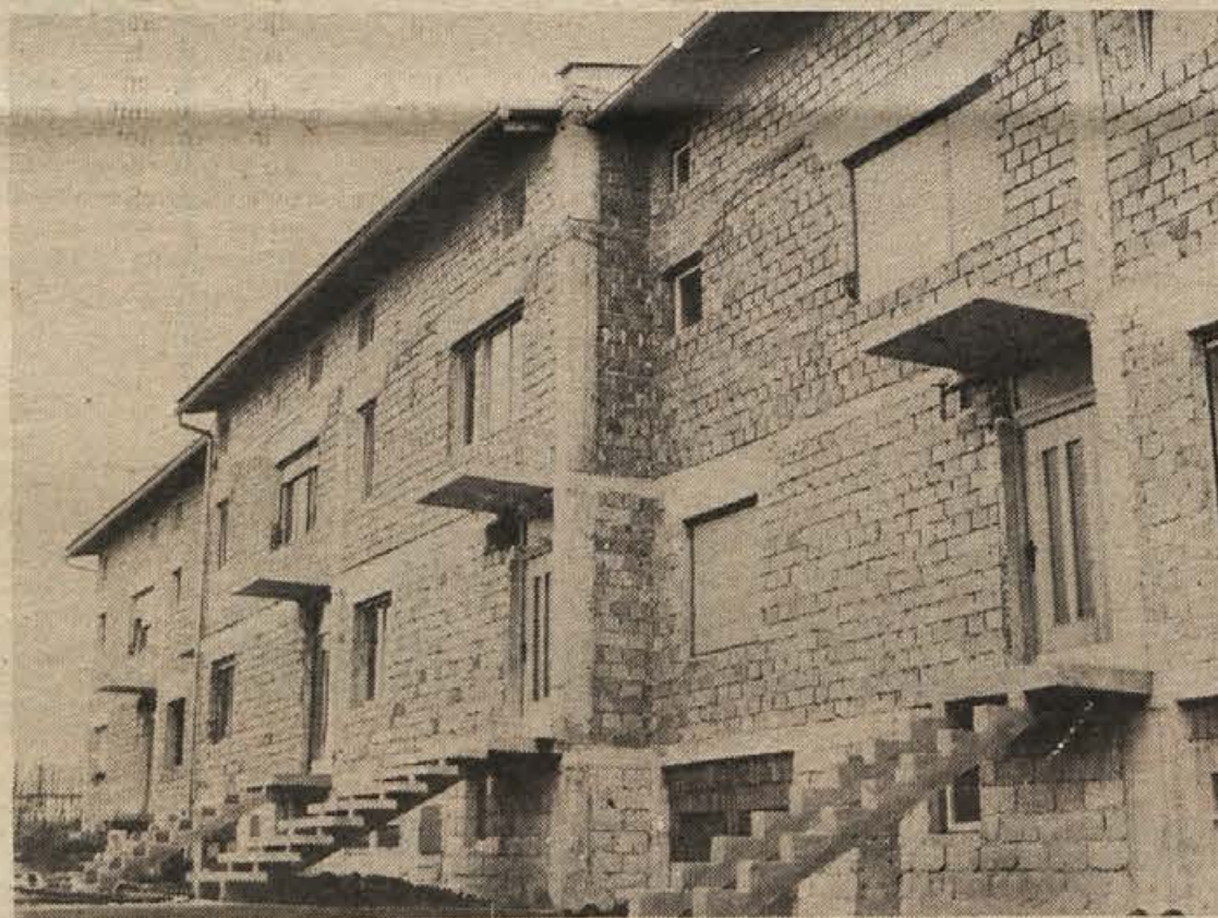
Vrstne hiše v Metliki, ki jih gradijo Kometovi delavci s pomočjo posojil, ki jih je odobril kolektiv
