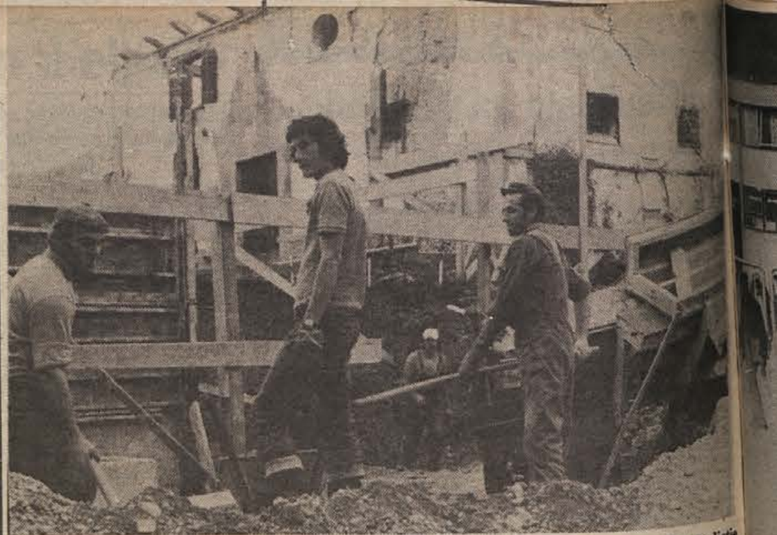
V Leskovcu gradi Pionir sodoben obrat za predelavo grozdja za proizvodnjo in trgovsko podjetje Agrokombinat Krško. Gradbena dela bodo končana ta teden. Predelovalno klet bodo začeli takoj opremljati, saj stroji že čakajo. (Foto: Jožica Tepepy)
