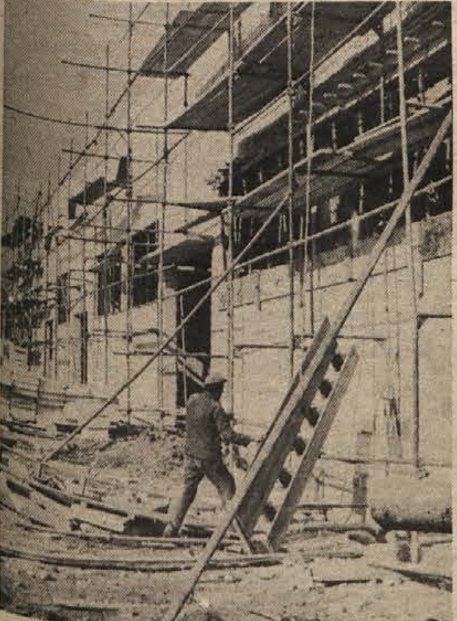
Nova velikanka – taka je nova livarna tovarne Cosmos – Belt v Črnomlju, kjer potekajo dela po načrtu. Podjetje bo s to rekonstrukcijo občutno povečalo zmogljivosti, uvedlo novo tehnologijo in se tako uvrstilo med najbolj iskane proizvajalce pri nas. (Foto: R. Bačar)
