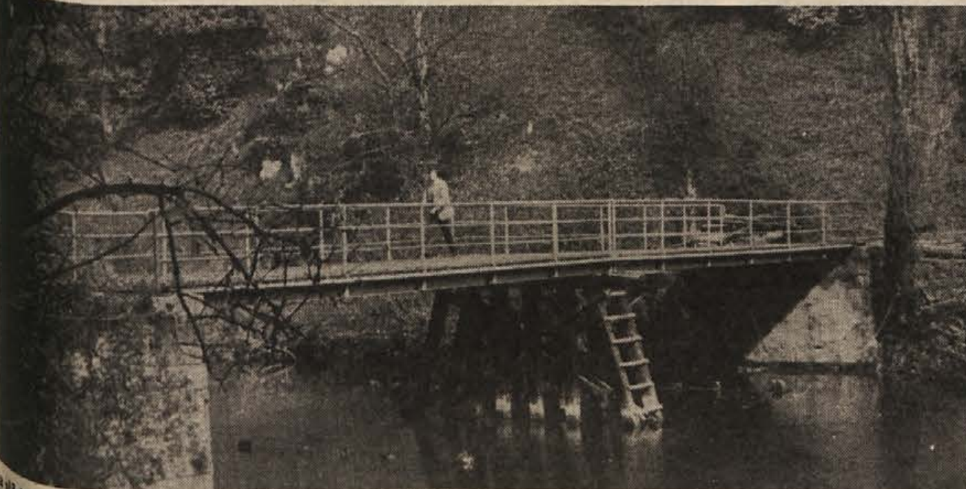
Obnovljeni 25-metrski most pri Drašči vasi je kombiniran – leseni piloti in jekleni nosilci. Na most so ponosni vsi občani, saj je od nje prebil pri obnavljanju precej ur – Foto: J. Pezelj
