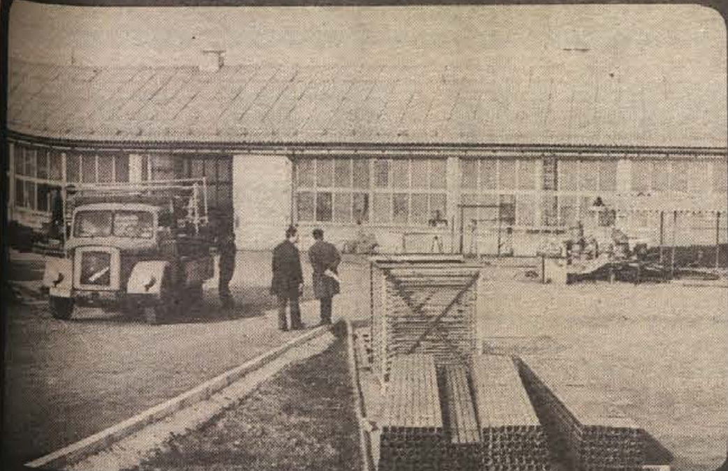
Bršlinski kovinarji so se dolgo počutili utesnjene, Marsikaj so morali delati na dvorišču. Tudi razvoj je zahteval, da morajo graditi. Stara hala (na sliki) je dobila sodobno dvojno 50 m stran.
