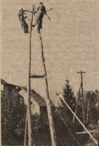
Obrat Elektra Celje obnavlja napeljavo od transformatorske postaje do železniške postaje v Brežicah. Stare, trhle drogeve bodo te dni zamenjali novi. (Foto: J. Teppey)
