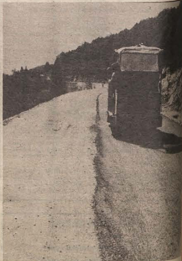
Drugi pododsek ceste Livold - Štalcerji, dolg nekaj nad 1000 m, začeli 6. septembra asfaltirati. Najprej so položili grobi, nato finejši asfalt. Tudi na prvi pododsek, dolg okoli 1.300 m, ki je grobo asfaltiran že lani, bodo položili letos fini asfalt, razen tega bodo v Livoldu asfaltirali še odcep pri prizišču proti Mozlju. (Foto J. Primc)
