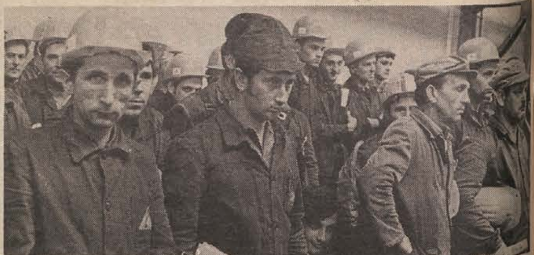
Iz rudnika na Senovem je prvega marca odšlo na delo v novi obrat Metalne 315 delavcev in 20 vajencev. V tovarni gradbenih žerjavov so se morali prekvalificirani rudarji zvesti v spreminjenem proizvodnjo, ki je zahtevnejša od dela v rudniških kovinskih delavnica. Do konca julija so imeli obdelati 659 ton materiala. Proizvodnja je začela naraščati šele v drugem polletju, vendar kaže, da bo kljub vsemu približala okvirnemu planu. (Foto: J. Teppey)
