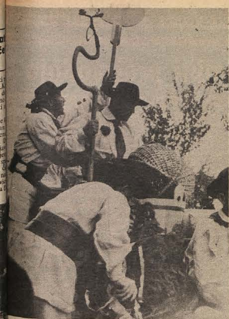
Delavci enote Elektro so prejšnji teden nameščali v središču mesta nove živostrežne svetilke na cestah. Ves ozi del Črnomla ima zdaj obnovljen in sodobnejšo javno razsvetljavo. (Foto: R. Bačer)
