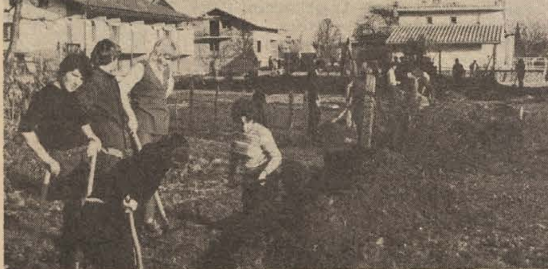
Kočevski mladinci so v enotedenski delovni akciji položili pod zemljo 300 m dolge električne kable za novi vrtec, ki je v gradnji, in tako zaslužili za svoje mladinske aktivne skupno okoli 10.000 din. (Foto: J. Primc)
