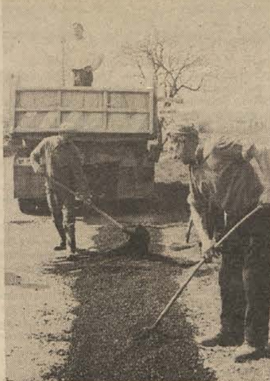
Delavci novomeškega cestnega podjetja so v pretežni meri že „zacementirali rane“, ki jih je na naših asfaltnih cestah napravila letošnja zima. Te dni opravljajo celo nekatera bolj zahtevna dela, saj jih čas tako ne lovi. Na sliki: urejevanje ceste pri Cikavi. (Foto: S. Dokl)
