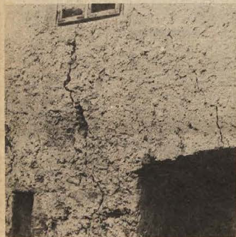
Drseča zemlja v Podplanini je povzročila pokanje zidov na nekaterih hišah (glej sliko), odnesla pa je tudi že del vaške poti – (Foto: Primc)
