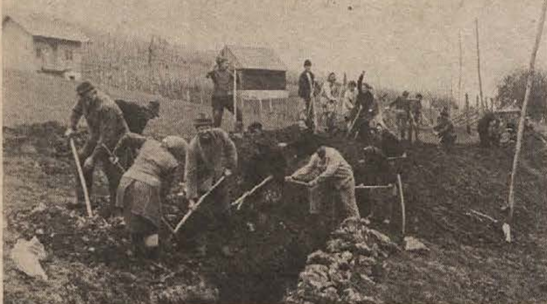
S sobotne delovne akcije med Žejnim in Cerino, kamor si vaščani napeljujejo vodovod. Trasa je speljana skozi kamenit svet, zato je bilo delo naporno in dolgotrajno. Ljudje prihajajo delat vsak dan, največ pa se jih zbere ob sobotah in nedeljah. (Foto: Baškovič)
