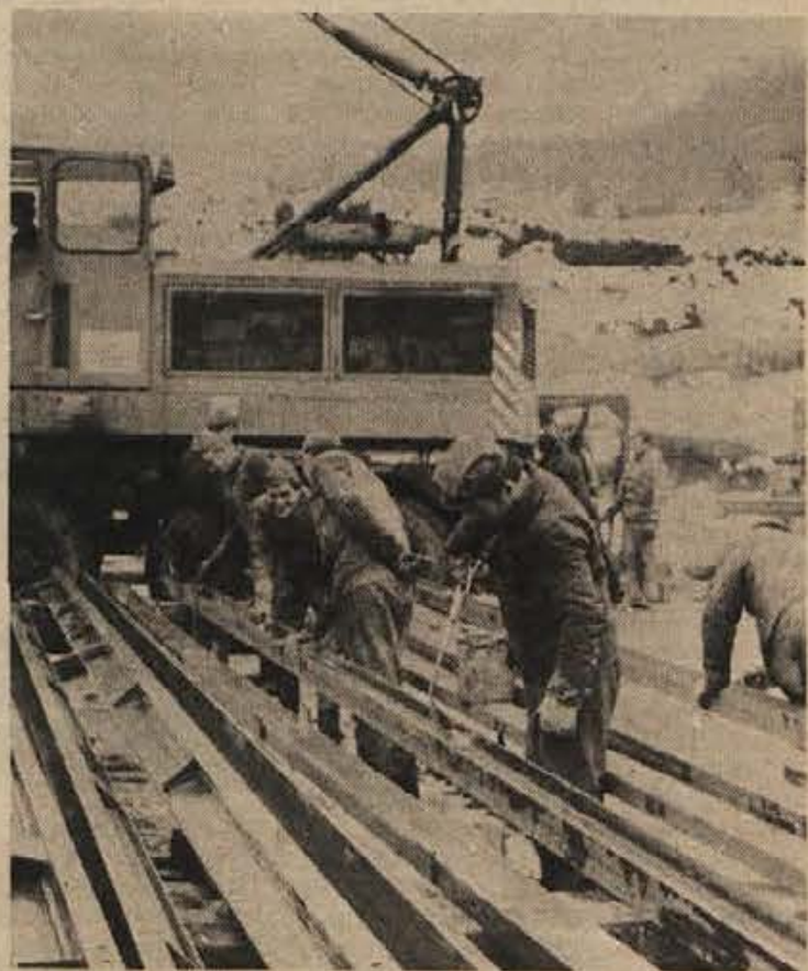
BREZ STREHE: dele za kovinske konstrukcije morajo najprej segreti in sušiti, preden jih lahko varijo ali barvajo. (Foto: Legan)
