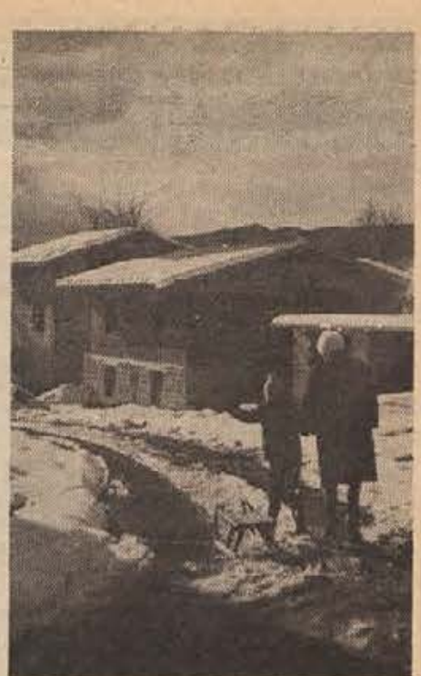
Več sto graditeljev hiš na Dolenjskem, v Beli krajini in v Posavju si je ob novem letu zaželelo le eno: da v letu 1972 cene gradbenemu materialu ne bi tako astronomsko rasle, kot so lani. Posnetek je iz novega naselja Čardak v Črnomlju. (Foto: R. Bačar)
