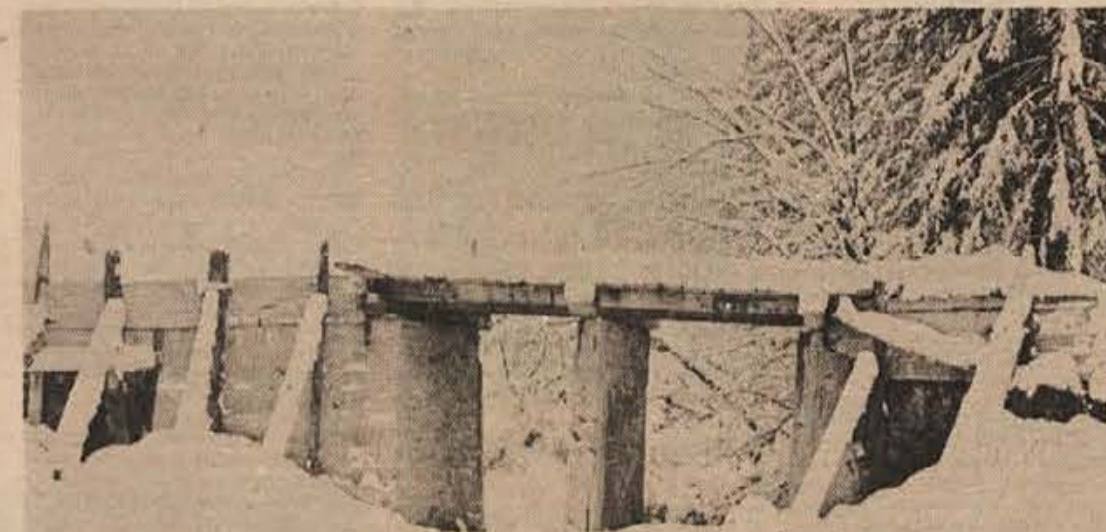
Namesto starega mostu na cesti Gor. Sušice-Verdun so čez potok Sušica začeli graditi novega, pa je delavce prehitela zima. Most so začeli graditi z denarjem in stroji prebivalcev Verduna in Gor. Sušice, Gozdne uprave Podturn ter krajevne skupnosti Dolenjske Toplice. (Foto: Stanko Avguštin)
