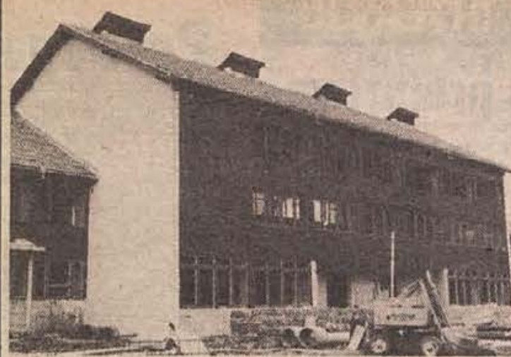
Čeprav nova šola v Loškem potoku še ni popolnoma dograjena, je že tako lepa, da možakarji ob nedeljah radi postajajo pred njo, jo občudujejo in zadovoljno kimajo. (Foto: J. Primc)
