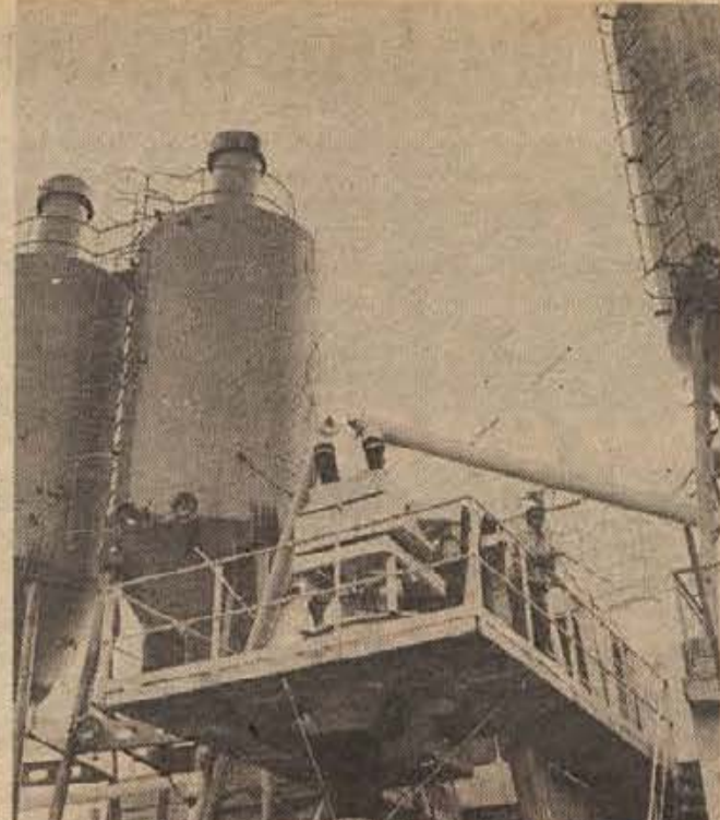
Gradbeno podjetje Pionir je postavilo v kamnolomu v Gotni vasi moderno avtomatsko betonarno zahodno-nemške izdelave. Na uro lahko napravijo 20 kubičnih metrov betona. V betonarni pripravljajo beton za vsa gradbišča novomeškega sektorja. (Foto: M. Vesel)
