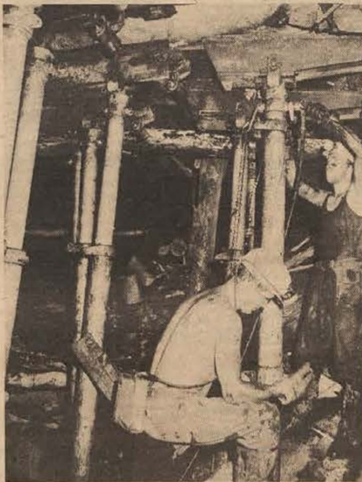
V rudniku Kanižarica letos verjetno ne bodo dosegli letnega proizvodnega plana, ki znaša 150.000 ton nakopanega premoga. Težave so zlasti zaradi produktivnih jamskih delavcev, ker jih ni, in zastarele transportne mehanizacije, potrebujejo pa tudi novo moderno hidravlično podporje, kakršno imajo zdaj samo na enem odkopnem čelu (na sliki). (Foto: M. Vesel)
