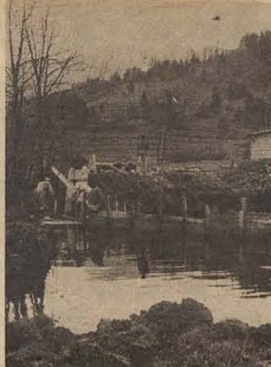
Šele pred kratkim so začeli resneje z deli za postavitve novega mostu čez Lipovščico pri Novi Stifci, čeprav bi moral biti po pogodbi dokončan že sredi oktobra. Dela - izvaja jih ZIDAR Kočevje - ovira zdaj tudi deževje. (Foto: J. Prime)
