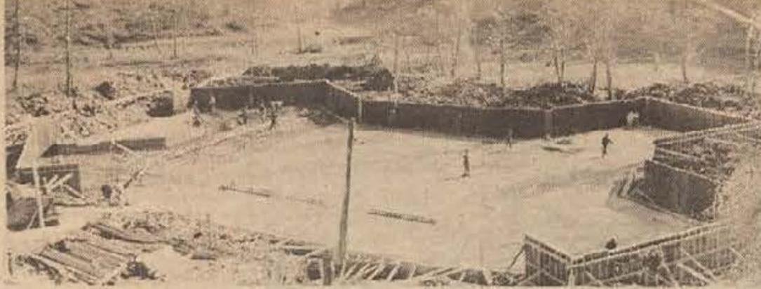
Obrisi zunanjega bazena so že lepo vidni; pred dnevi so delavci Pionirja betonirali nosilno ploskev, ki je zahtevala posebne gradbene prijeme. (Foto: S. Dokl)
