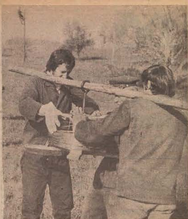
Novomesko PTT podjetje je prejšnji teden opravljalo redna vzdrževalna dela na telefonskem omrežju med Suhorjem in Metliko. Zeleno zico so zamenjali z bakreno, zato se bo slinost verjetno izboljšala. Zadnji čas, kajti govoriti po telefonu z Belo krajino je prava muka. (Foto: R. Bačer)
