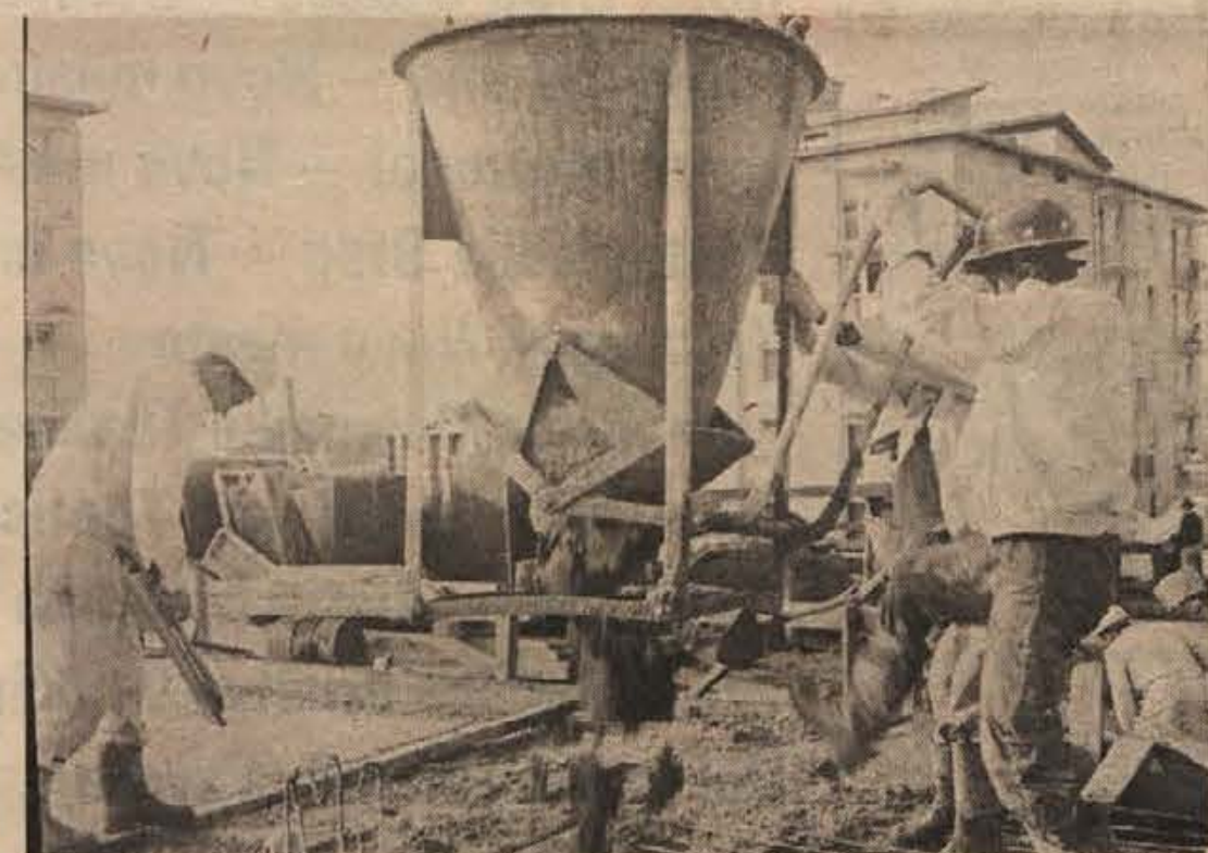
Pogled na največje in najbolj urejeno stanovanjsko naselje v Novem mestu. Naselje Nad Mlino je v celoti zgradilo in uredilo gradbeno podjetje PIONIR (spodaj), zgoraj pa vidimo Pionirjeve delavce pri betoniranju plošče na stolpnici, ki jo sedaj gradijo.
