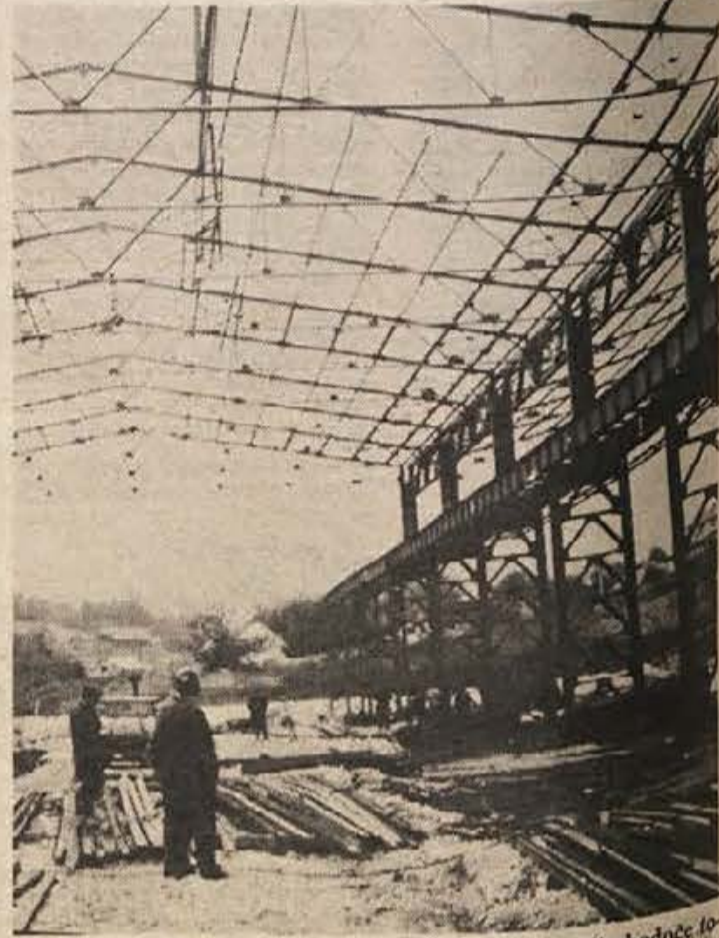
Na gradbišču Metalne montirajo železno konstrukcijo bodoče tovarne gradbenih terjavov. Proizvodna dvorana bo dograjena konec leta. (Foto: J. Teppey)
