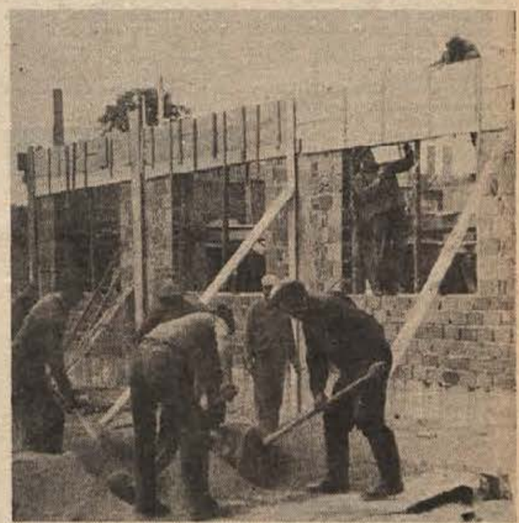
Pod vodstvom Petra Marinčiča delajo vaščani Starega trga, Sodeve in Vrta (na sliki) kot bi šlo za stavo. Nekaj je plačanih, še več prostovoljcev, delo pa zgledno napreduje. (Foto: R. Bačer)
