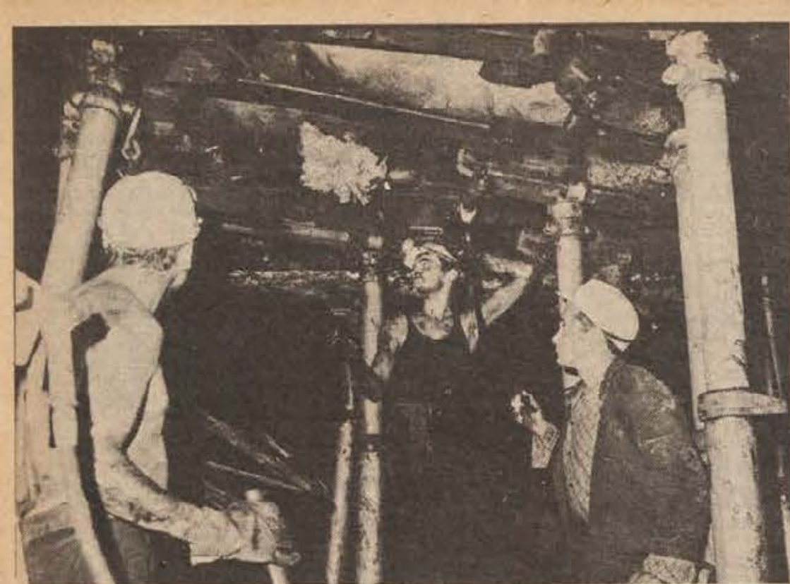
Tekočina v hidravličnih napravah pomika stropnike in podpornike v želeno smer. Podpiranje jame je sedaj enostavnejše in varnejše. (Foto: M. Vesel)
