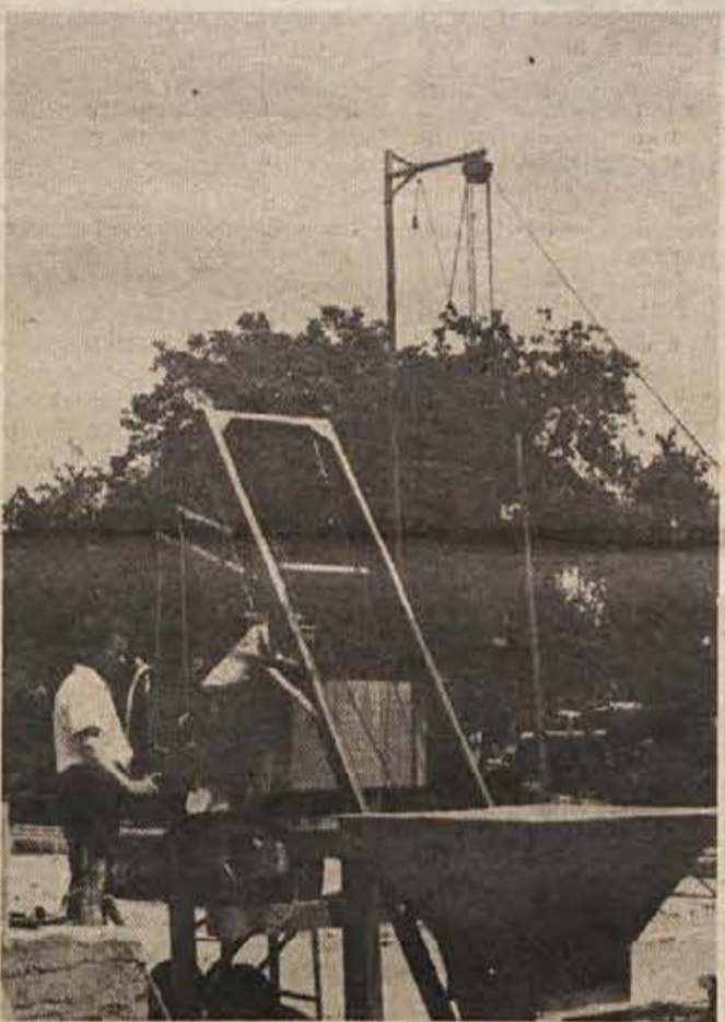
Zadnja novost, delo Viktorja in Pavleta: betonski krožni mešalec s kablo in mehanično lopato. Od zveznega patentnega zavoda, kjer ima Viktor prijavljenih 12 izumov, pričakujeta v kratkem odgovor.
