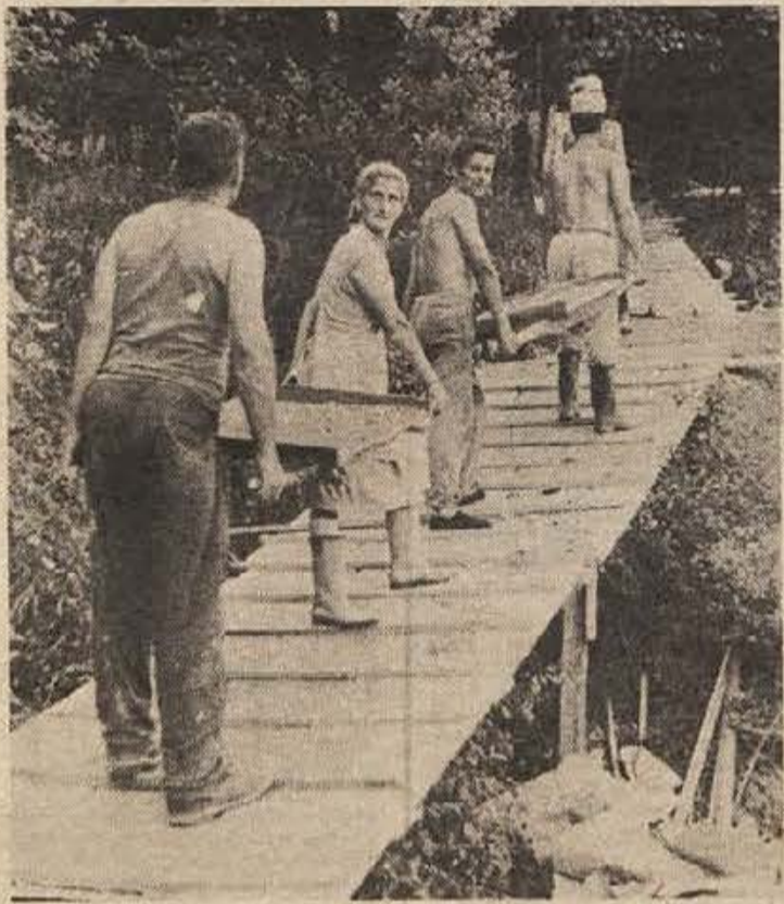
Občani Dolnje Straže in Podgore so se z veliko vnemo lotili gradnje vodovoda. Na sliki: vaščani gradijo vodovodni zbiralnik (Foto: S. Dokl)
