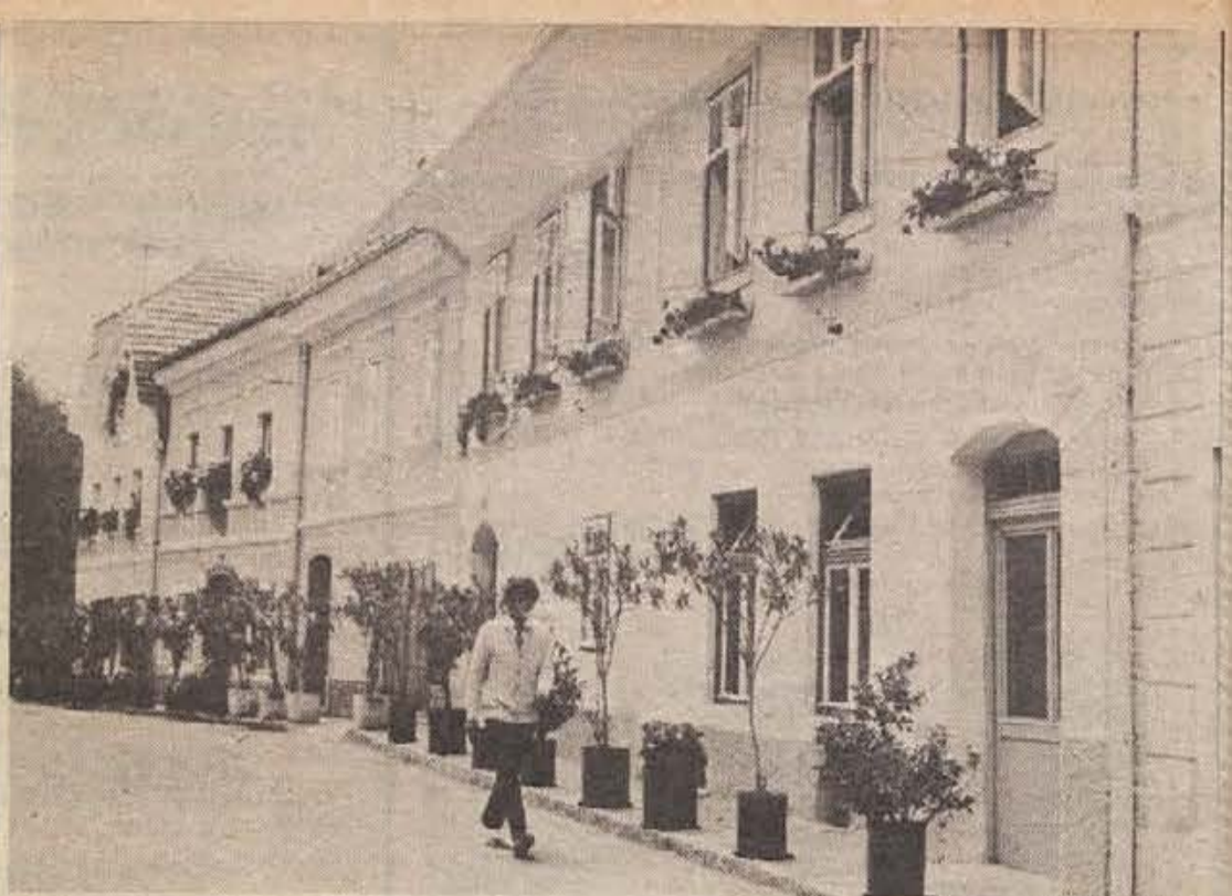
Tancikova hiša na Mestnem trgu v Metliki je ohranila vse značilnosti stare meščanske hiše, čeprav jo je lastnik preuredil in pred kratkim prebelil. Rože na podstavkih pri oknih te hiše in na oknih njenih sosed vzdolž ulice dokazujejo, da Metličani poznajo lepoto, pa tudi red in čistočo. (Foto: Ivan Zoran)
