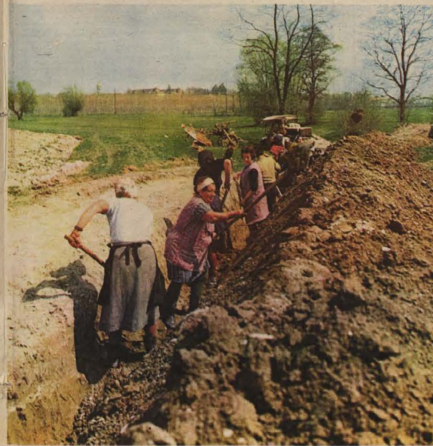
Zadnja leta vedno več oddaljenih krajev dobiva vodovod. Največ zaslug za to imajo občani sami, saj prispevajo s prostovoljnimi delomi in denarju. Posnetek kaže delovno akcijo vaščanov Krške vasi, ki si bodo do jeseni napeljali iz Brezic pitno vodo. (Foto: E. Vesel)
