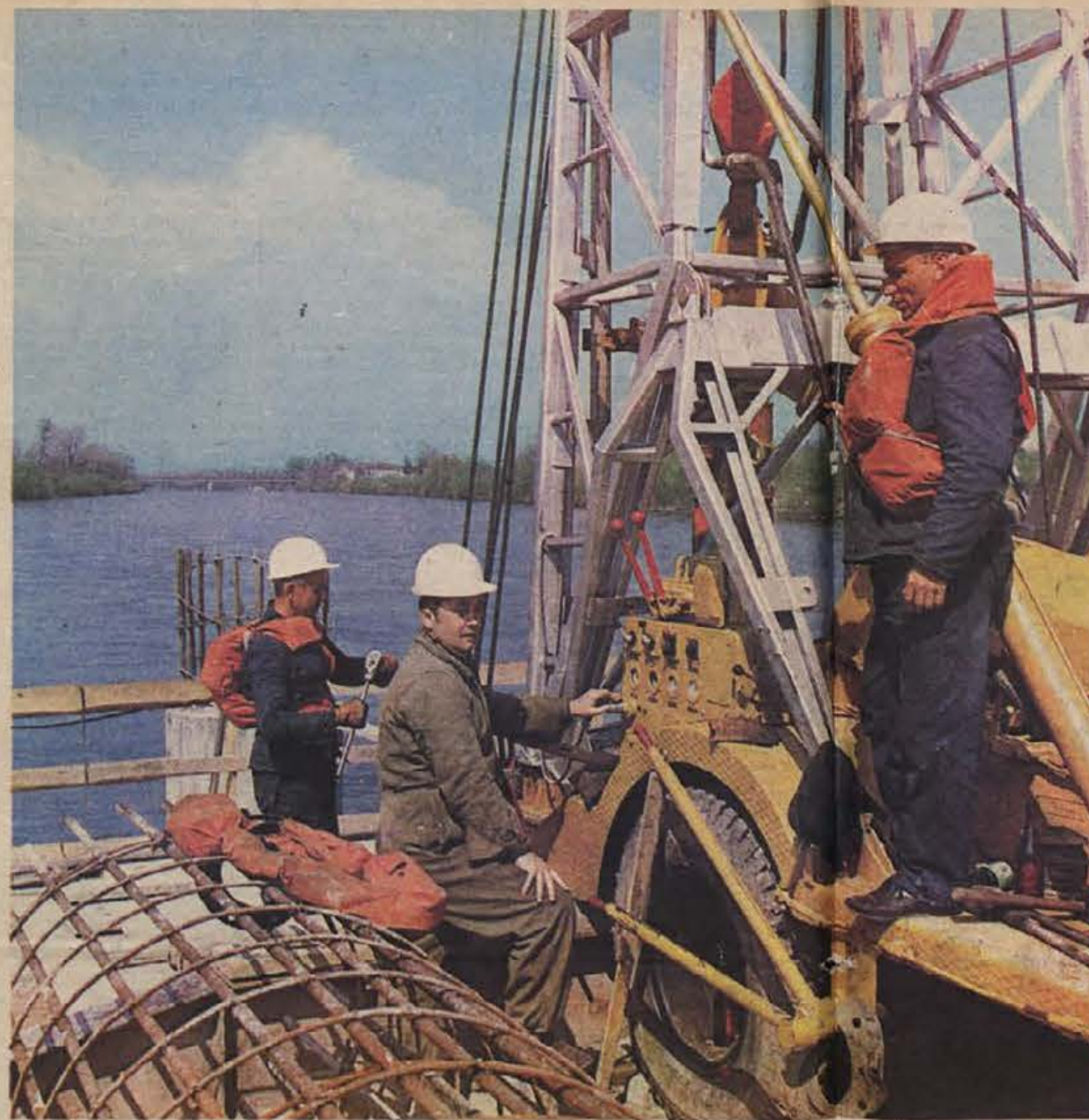
Najzahtevnejše delo pri graditvi novega brežiškega mostu čez Savo je bilo betoniranje železobetonskih pilotov v rečni strugi. Po neviščnosti, ko se je potopil velik splav z drago napravo, so strokovnjaki zagrebske Geotehnike delo uspešno opravili. (Foto: M. Vesel)
