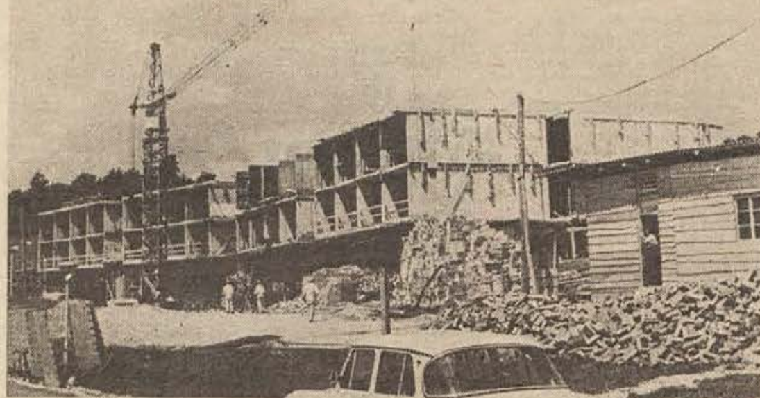
Do konca letošnjega leta bodo na Otočcu dobili nov hotel B-kategorije, ki bo imel 210 ležišč. V objektu bo tudi velika konferenčna dvorana in plavalni bazen. Na sliki: gradnja hitro napreduje, objekt že kaže svojo bodočo podobo. (Foto: S. Dokl)
