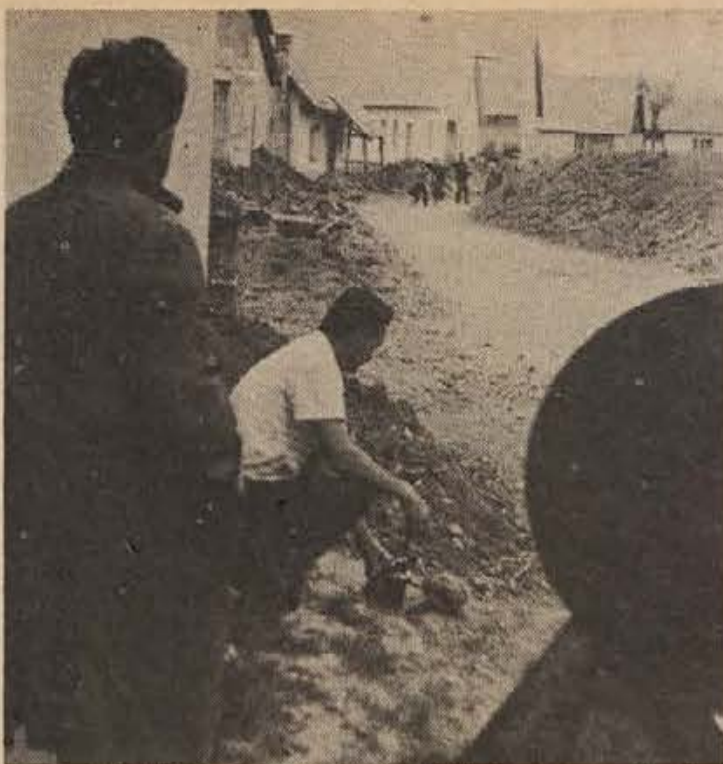
Pri kopanju jarkov za vodovod so v Željnah pogosto našli na skale, zato so morali poklicati na pomoč minirerje. (Foto: Jože Primc)
