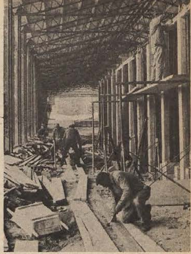
Opekarna Kanizarica bo podvojila zmogljivost, ko bo začela obratovati v novih prostorih. Gradbena dela v 1500 kvad. metrov veliki proizvodni hali so skoro končana, zdaj pa strokovnjaki opravljajo montažo strojev. (Foto: Ria Bačar)
