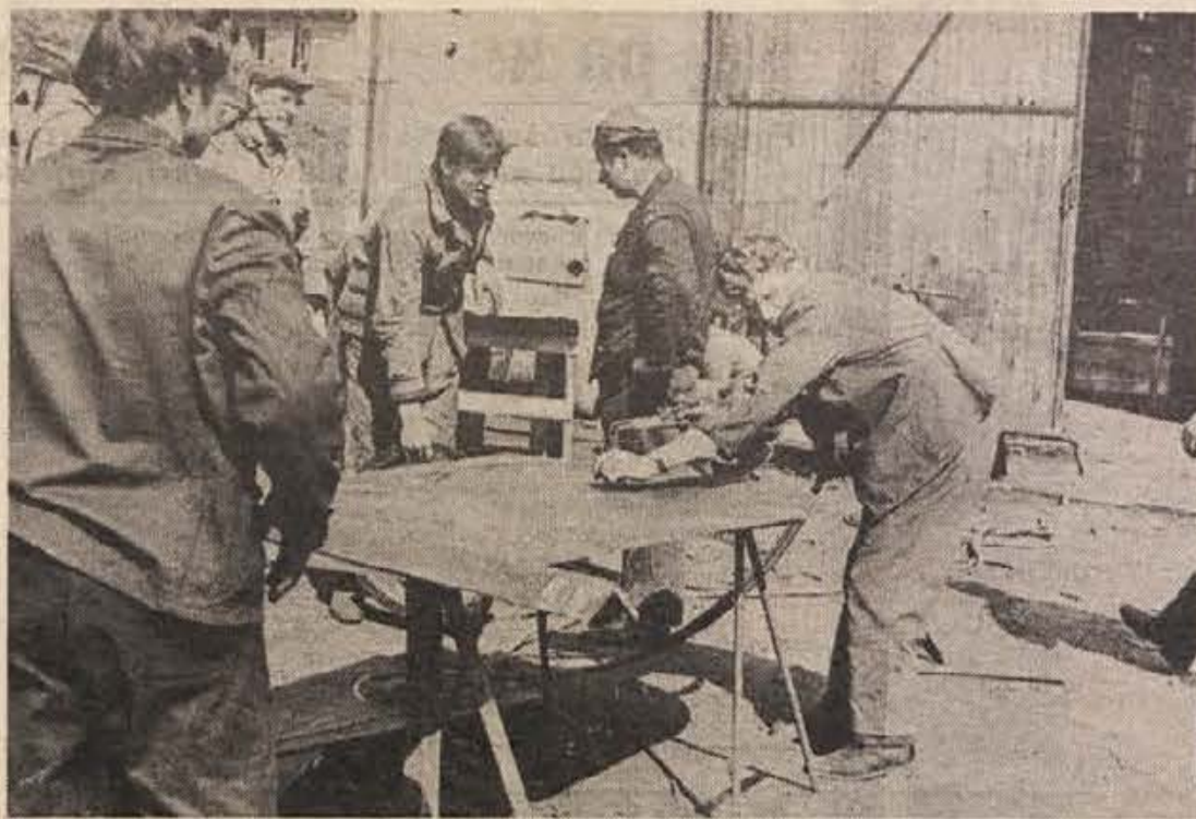
Pred delavnico novoustanovljenega podjetja INKOT v Trebnjem, ki se uveljavlja s svojimi klimatskimi in prezračevalnimi napravami. (Foto: Legan)
