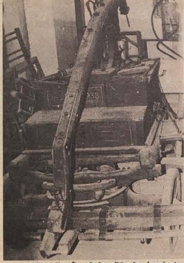
Ročna gasilska črpalka v Žužemberku sodi že v čase, ko se je v tem delu Suhe Krajine začela razgibana gasilska dejavnost. (Foto: S. D.)
