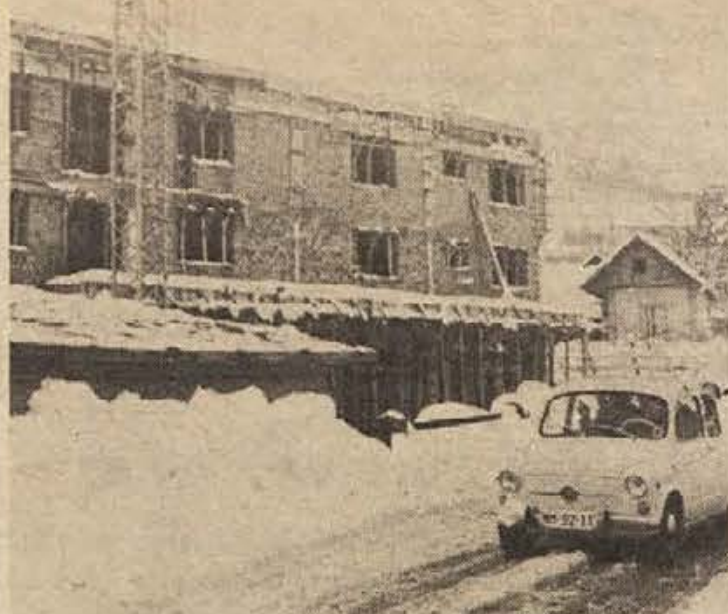
V Semicu napreduje gradnja velike samopostrežne trgovine, ki jo investira ljubljanska Prehrana, ter gradnja stanovanjskega bloka. Občani z zanimanjem spremljajo dela na gradbišču nasproti osnovne šole. (Foto: Ria Bačer)
