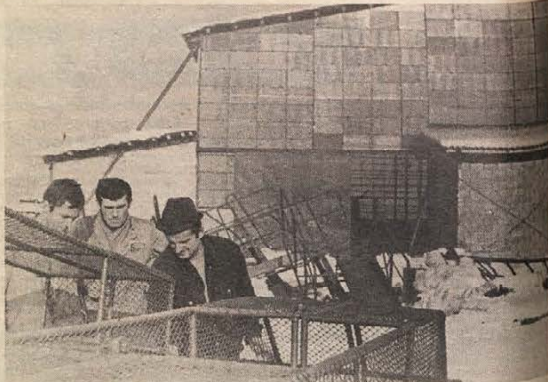
Do letošnje zime so morali sevniški kovinarji delati tudi v mrazu in dežju brez strehe nad glavami, vendar so vztrajali. Celotno več: po stopnji rasti celotnega dohodka so zadnja leta med prvimi podjetji občine. Zdaj, ko so pri žagi zgradili proizvodno dvorano, veliko 1200 kvadratnih metrov, se bodo izboljševale tudi delovne razmere, ki so bile doslej težke kot nikjer drugje. Na sliki: delovni razgovor kovinarjev, v ozadju nova stavba. (Foto: Legan)
