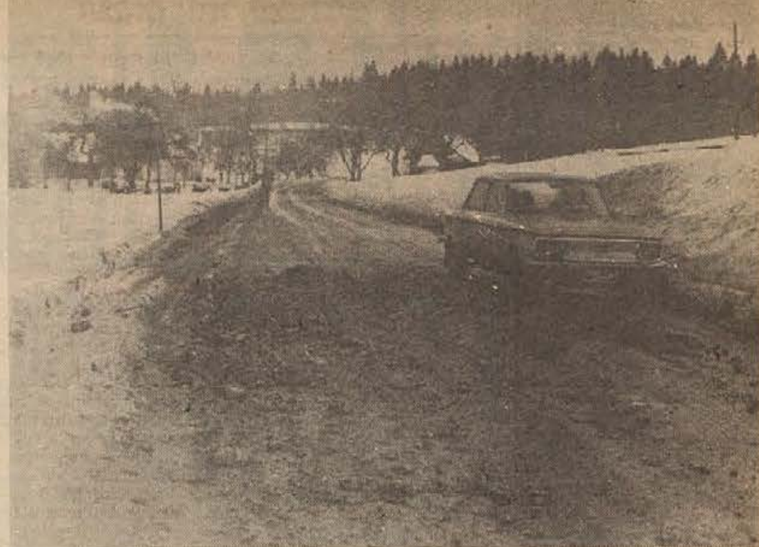
RAZRITE CESTE NA DOLENJSKEM — Čeprav zime še ni konec, so se na dolenskih asfaltiranih cestah že pokazale posledice mraza. Nekatere ceste so tako razrite, da so skoraj neprevozne. Najhuje je izdelana in razorana asfaltna cesta Novo mesto—Straža, kjer se pozna, da je cesta preobremenjena; teži tovorni promet je torej le zahteval svoj davek. Na sliki — Voznik se umika jamam pri Volavčah, pri takšnih obvozih pa lahko pride tudi do nesreče, saj vozniki vozijo po levi strani ceste. (Foto: S. Dokl)
