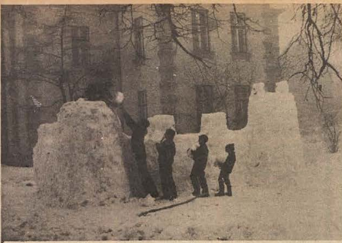
Črna bela gradnja, in to na vrtu občinske skupščine Ribnica. Upamo, da se bodo krivci zagovarjali pred sodiščem. Krivci pa upajo, da bo pred obravnavo pomladanski sonček zbrisal dokaze. To gradnjo naj bi si ogledali tudi starejši gradbinci, katerih gradnje trajajo včasih po 20 in več let, pa čeprav niso dosti večje od te na sliki (Foto: Drago Mohar)
