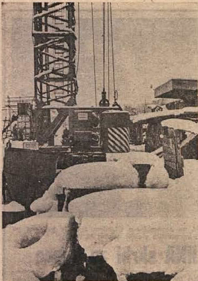
V Stari vasi pri Krškem gradi podjetje PIONIR novo pekarno. Investitor je ZITO iz Ljubljane. Snega se na gradbišču niso ustrašili. Delo bodo nadaljevali, dokler ne bo zmrzovalo. (Foto: Jožica Teppey)
