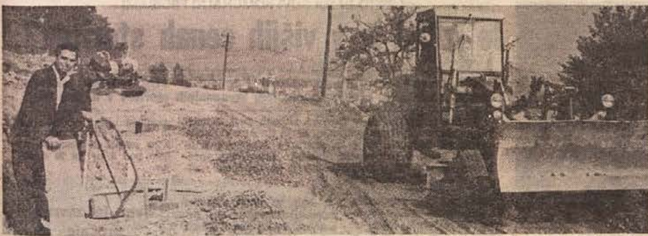
Cestno podjetje asfaltira cesto proti Leskovcu. Delo je organizirala krajevna skupnost, ki ji je priskočila na pomoč občinska skupščina. (Foto: J. Teppey)
