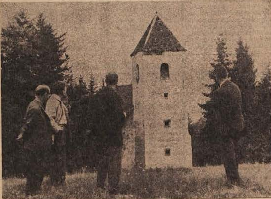
Kapela sv. Jurija pri ortneškem gradu (iz 17. stoletja) je precej poškodovana (podrt strop itd.), ker ni bilo denarja za nekaj kvadratnih metrov opeke. Ko je bila škoda še precejšnja, so kapelo le pokrili in zaščitili pred nadaljnjim propadanjem. Ime je dobila po sliki sv. Jurija, ki jo je naslikal znameniti novomeški slikar H. G. Geigerfeld (Foto: Primo)
